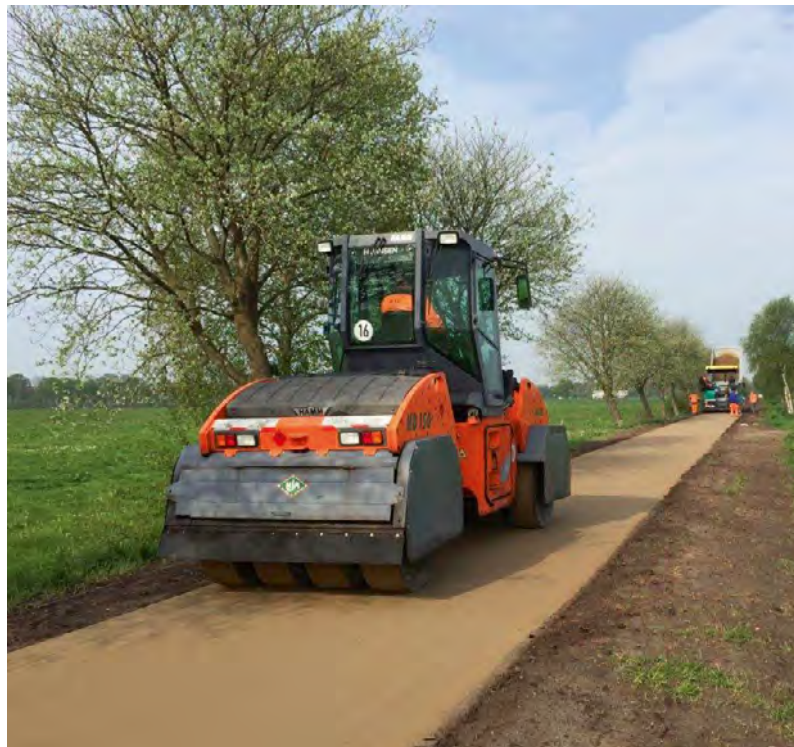
Schweres Gerät im Wegebau
